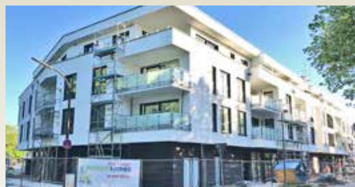
Geschäftshaus an der Lindenstraße
